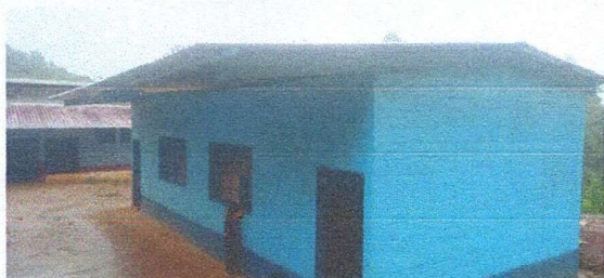
Foto 3: Vista cubierta de lamina troquelada nueva.
